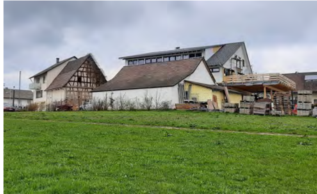
Abb. 19: Gebäude verschiedener Baujahre mit Quartierpotenzial für Fledermäuse (Teilbereich A, Grünfläche im Vordergrund ist Teilbereich B).
